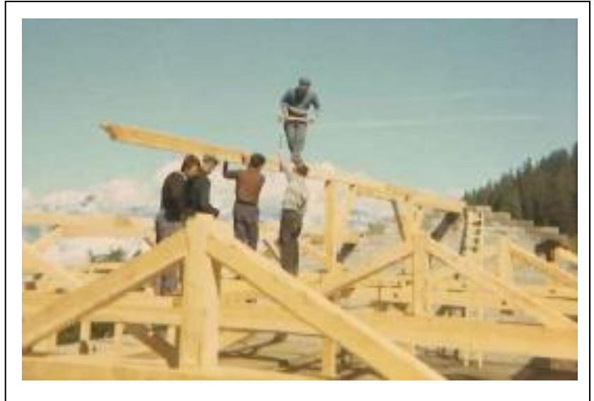
Construction de l'étable de Prabé 1966 Photo Collection Marius
